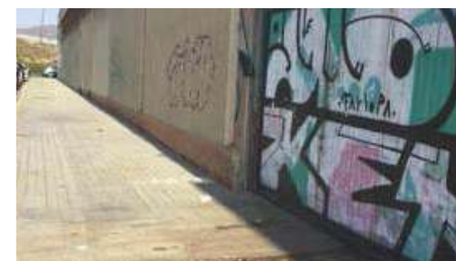
Façanes cegues, sense elements urbans i poca diversitat d'usos, carrer del Ferrocarril
