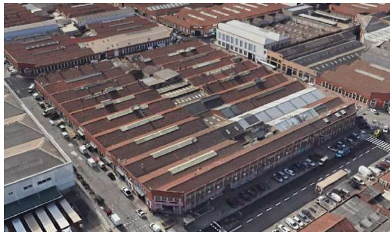
Figura 6.6. Imatge de la tipologia tipus de nau entre mitgeres Font: Google Earth
