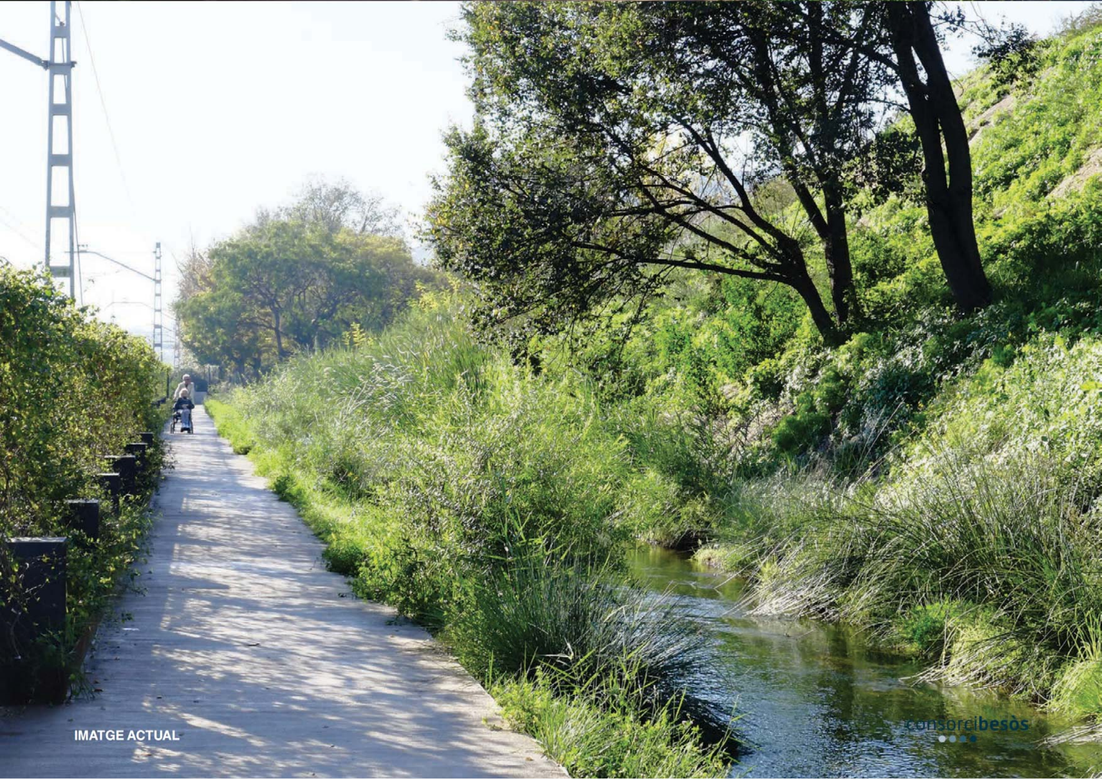
IMATGE FINALITZACIÓ OBRES
