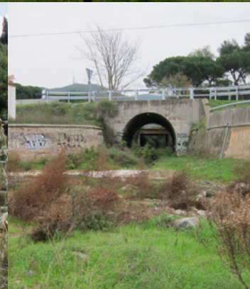
Pont connector a la carretera de la Roca (CB)
