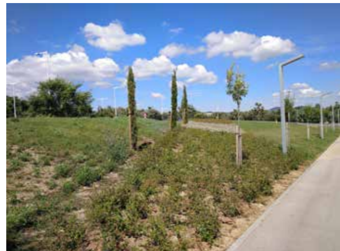
RECEPCIÓ de les obres del "Projecte d'enjardinament del sector de la Catalana. Fase III i Projecte d'Urbanització del Sector de la Catalana, Fase III, Subfase IV al Terme Municipal de Sant Adrià de Besòs.
