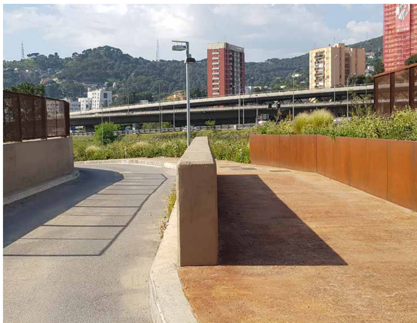
Obres relatives al Projecte del Nou Pont de pas sobre les vies del ferrocarril a l'Avinguda Puig de Jorba dins del Pla de Millores de la Mobilitat al Barri Vallbona de Barcelona.
