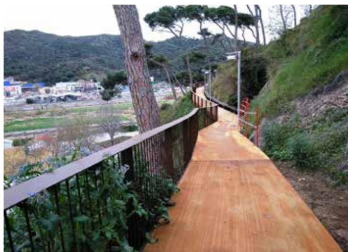
RECEPCIÓ de les obres contemplades en el Projecte de connexió per a vianants entre els carrers Oristà i Bosc i arranjamet del talús entre el carrer Oristà i el Rec Comtal
