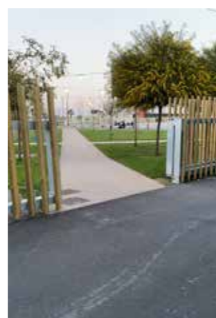
RECEPCIÓ de les obres contemplades en el Projecte Executiu de la tanca del Parc del Campus Diagonal-Besòs.
