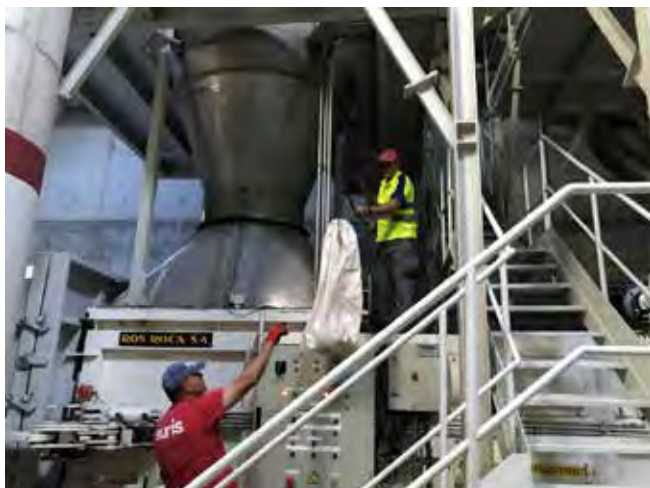
RECEPCIÓ Obres de instal·lació i posada en marxa del sistema de recollida neumàtica dels sectors I, II i III de la Catalana
