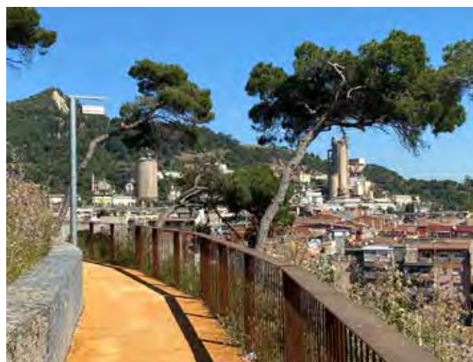
RECEPCIÓ parcial Connexió per a Vianants entre els carrers Oristà (Vallbona) i Bosc (can Sant Joan) i d'Arranjament del Talús comprès entre el carrer Oristà i el Rec Comtal, als termes municipals de Barcelona i Moncada i Reixac
