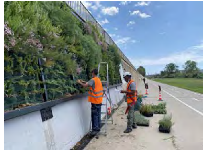
Prova pilot mur verd del Besòs: Posada en marxa d'una prova pilot per avaluar la viabilitat tècnica i econòmica d'un tram de jardí vertical en el mur d'endegament del Parc Fluvial del Besòs amb l'objectiu de reforçar el seu paper com a refugi climàtic i potenciar la biodiversitat.
