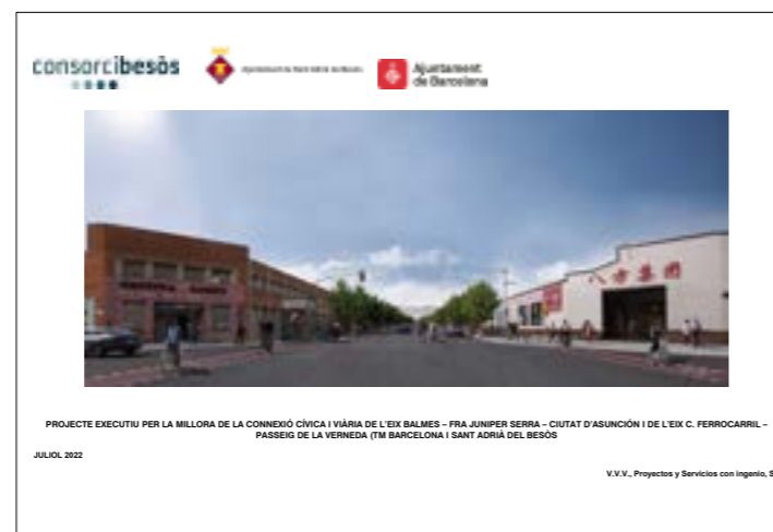
Redacció del projecte executiu per a la millora de la connexió cívica i viària de l'eix Balmes-Fra Juniper Serra-Ciutat d'Asunción i de l'eix Carrer Ferrocarril-Passeig de la Verneda (V.V.V. Proyectos y Servicios con ingenio, SL)
